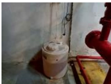
ระบบเติมคลอรีนถังพักน้ำ
