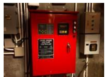
ระบบ Engine ใช้น้ำมันเดินปั๊มฉีดน้ำดับเพลิงกรณีไฟฟ้าดับ
