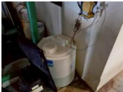
ระบบเติมคลอรีนถังพักน้ำใช้
