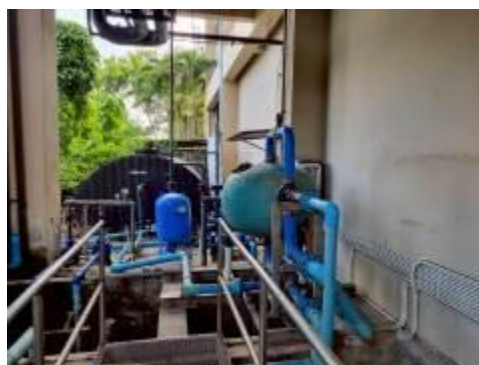
ระบบ Reuse น้ำทิ้งหลังบำบัด
