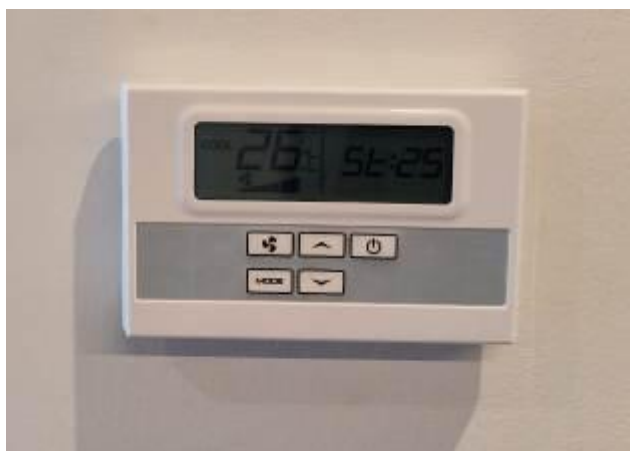
ชุดควบคุมอุณหภูมิห้องปรับอากาศ
